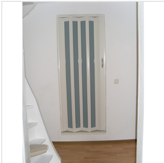
Türe zum Nebenraum 1.OG
